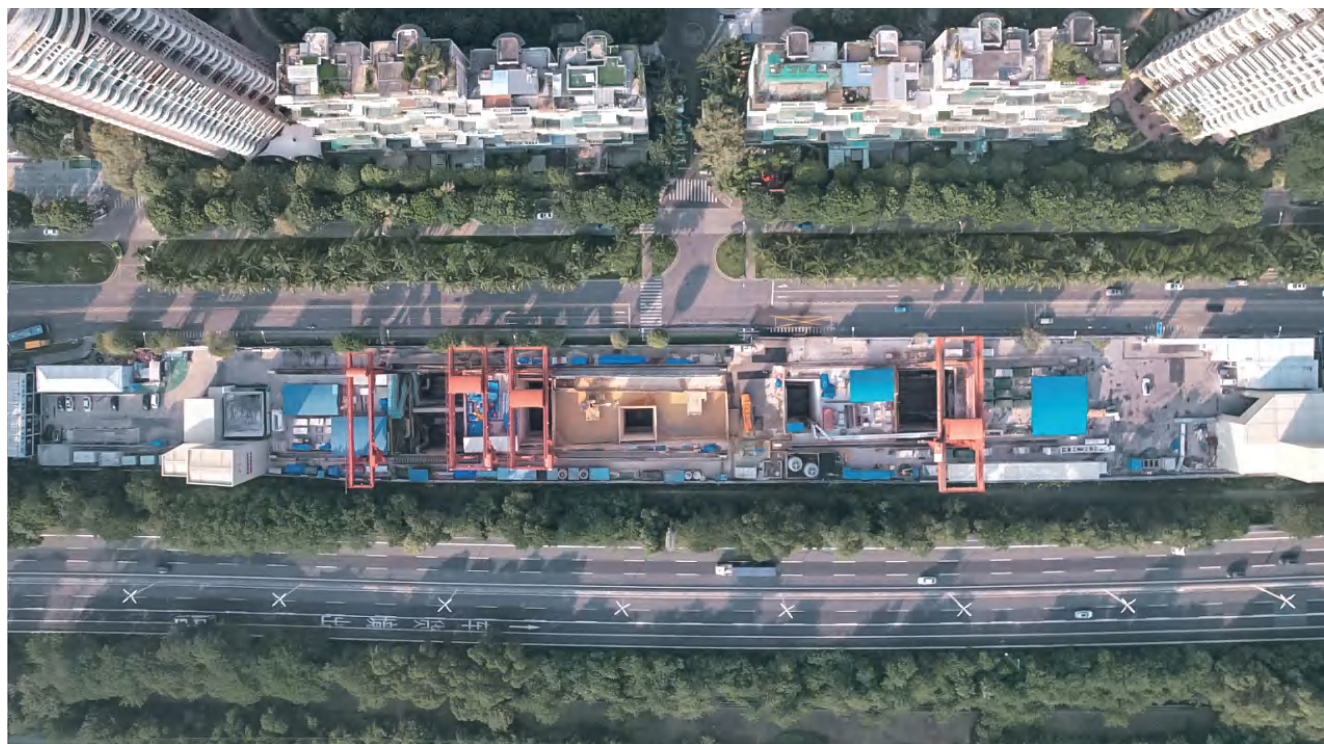
穗莞深前皇先开段二工区项目实景图
