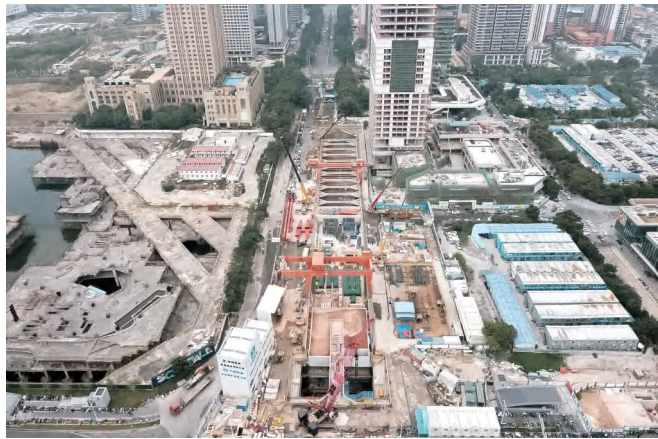
深惠城际二标项目实景图
