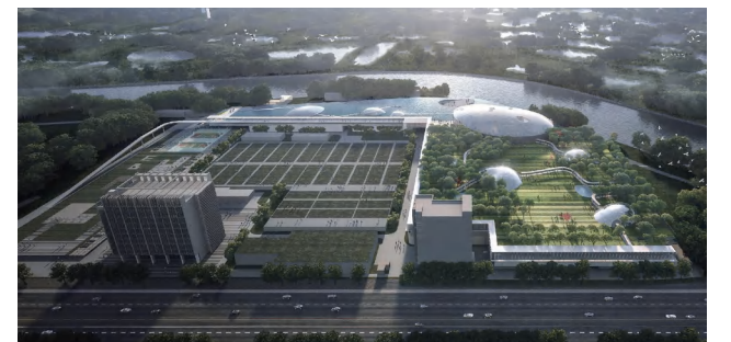
滨河水厂扩建工程
