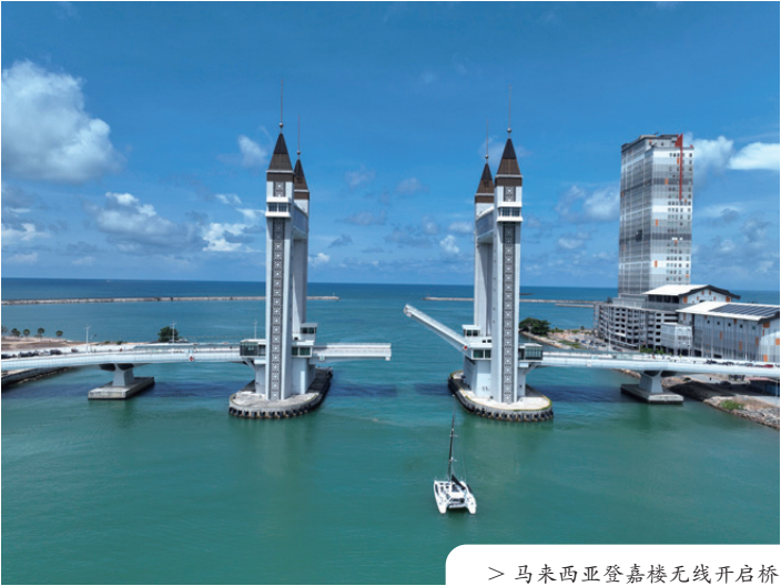
> 马来西亚登嘉楼无线启桥
