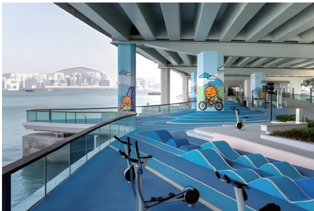
> 香港东岸板道西段滨海公共空间
