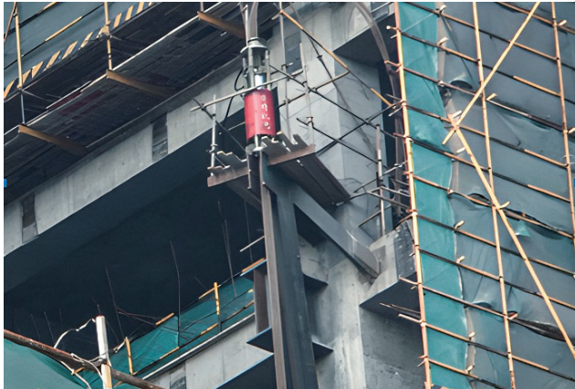
> 图 13 连廊提升平台水平构造实际应用
