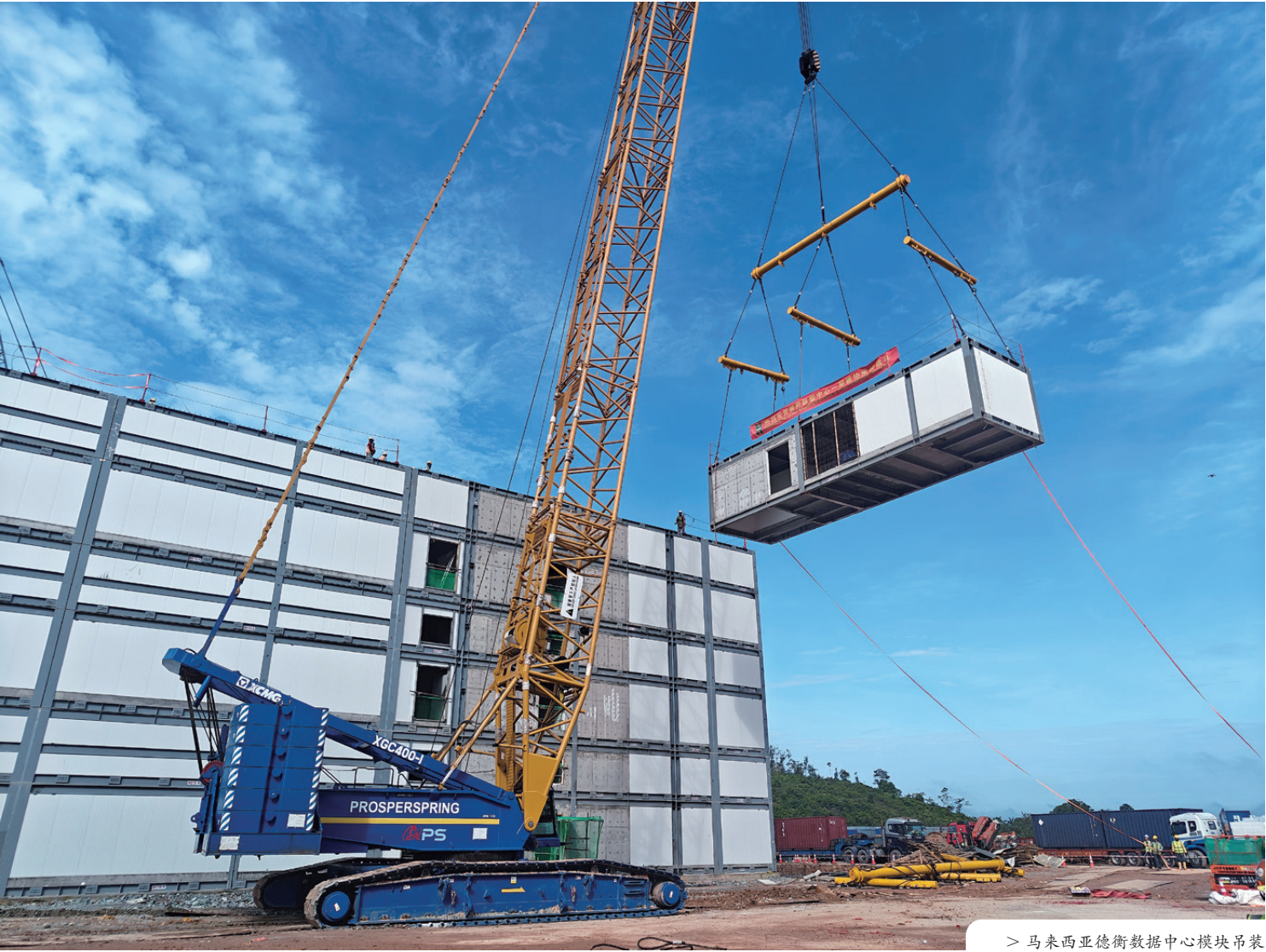
> 马来西亚德衡数据中心模块吊装
