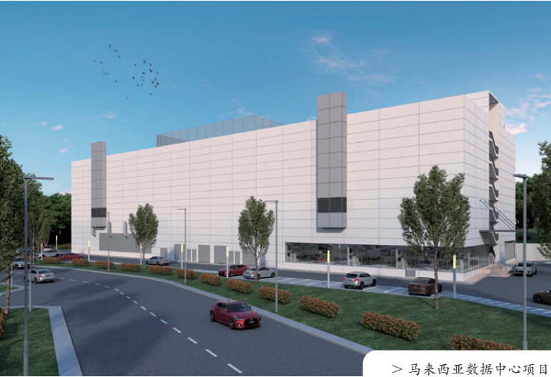
> 马来西亚数据中心项目
