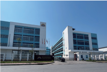
> 汇进越南一期厂房
